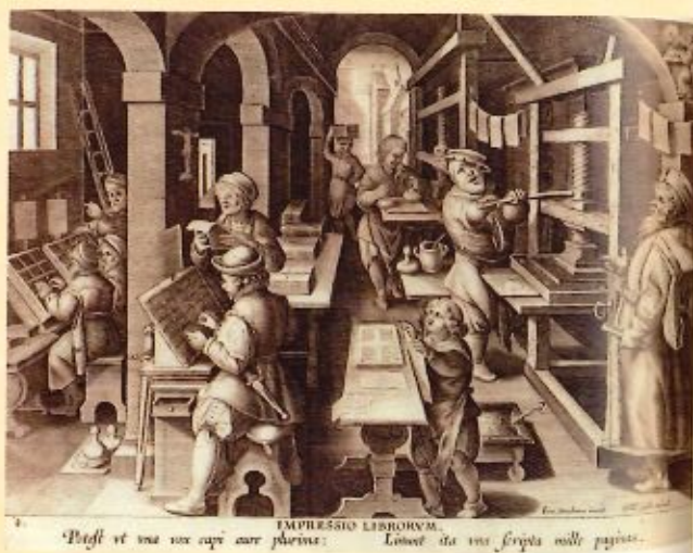
5. Un atelier d'imprimerie, Jan Van Der Straet dit Stradanus, gravure en taille-douce, Anvers, ca 1600, Bibliothèque royale de Belgique, Cabinet des Estampes, Bruxelles (SI1514). On peut observer toutes les étapes de l'imprimerie d'un livre au XVI e siècle.
