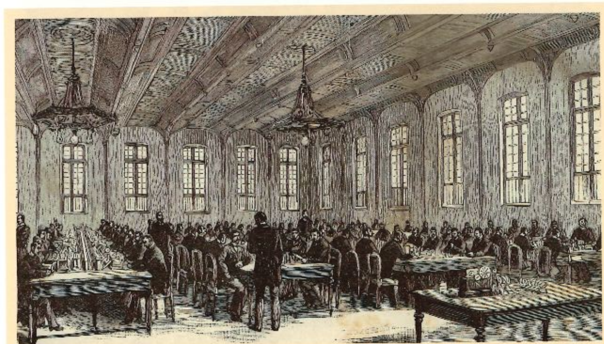
6. Salle des transmissions de la station centrale des télégraphes de Paris, gravure.
