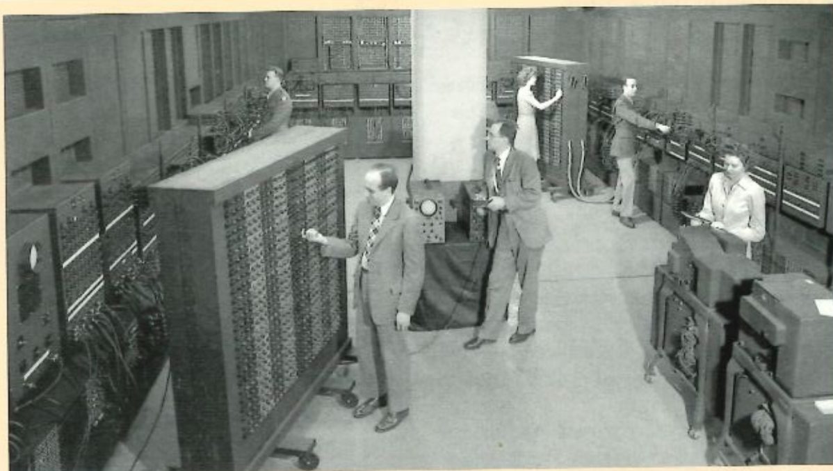
3. ENIAC . Ce premier calculateur entièrement électronique peut multiplier deux nombres de dix chiffres en moins d'une demi-seconde. Il pèse trente tonnes et contient des milliers de tubes électroniques mais aucune mémoire de programme.
